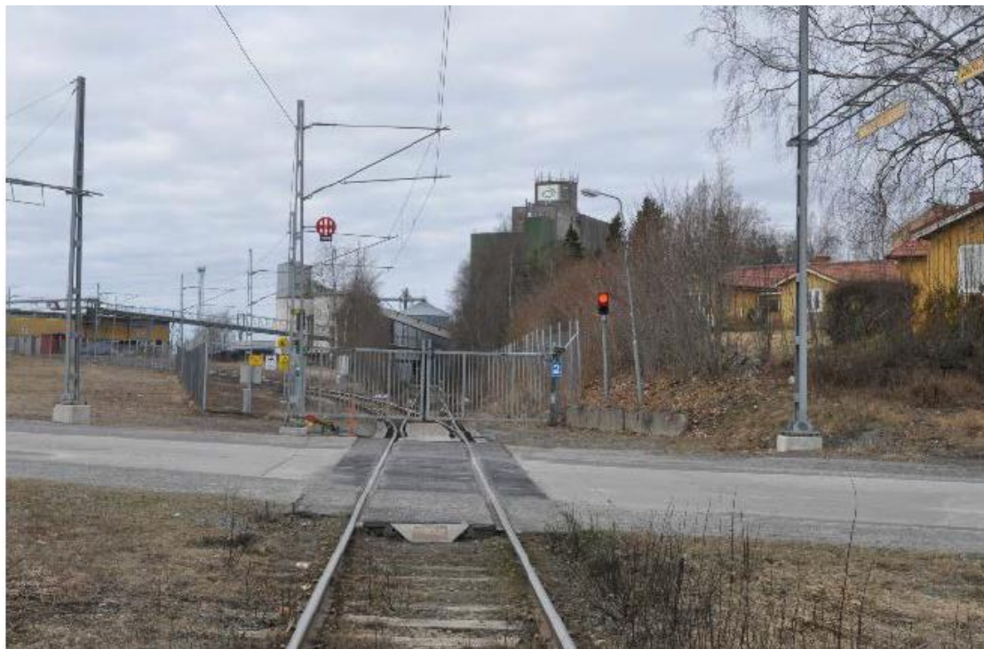
Figur 20 Järnvägs korsning vid Axel Enströms väg.
