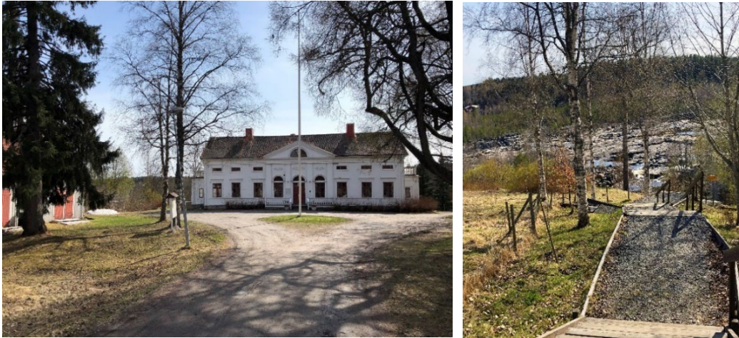
Figur 8. Baggböle herrgård som ligger ca 500 meter söder om planområdet och som tillsammans med tillhörande parkmiljö är skyddad som byggnadsminne.
