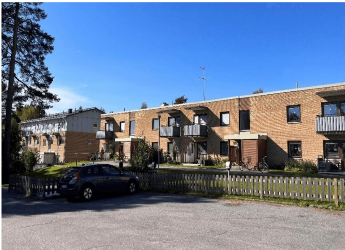
Figur 8. Huvudbyggnad för fastigheten Vindfället 9 sedd från fastighetens parkering
