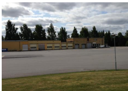
Byggnader vid södra fastighetsgränsen, som föreslås rivas.
