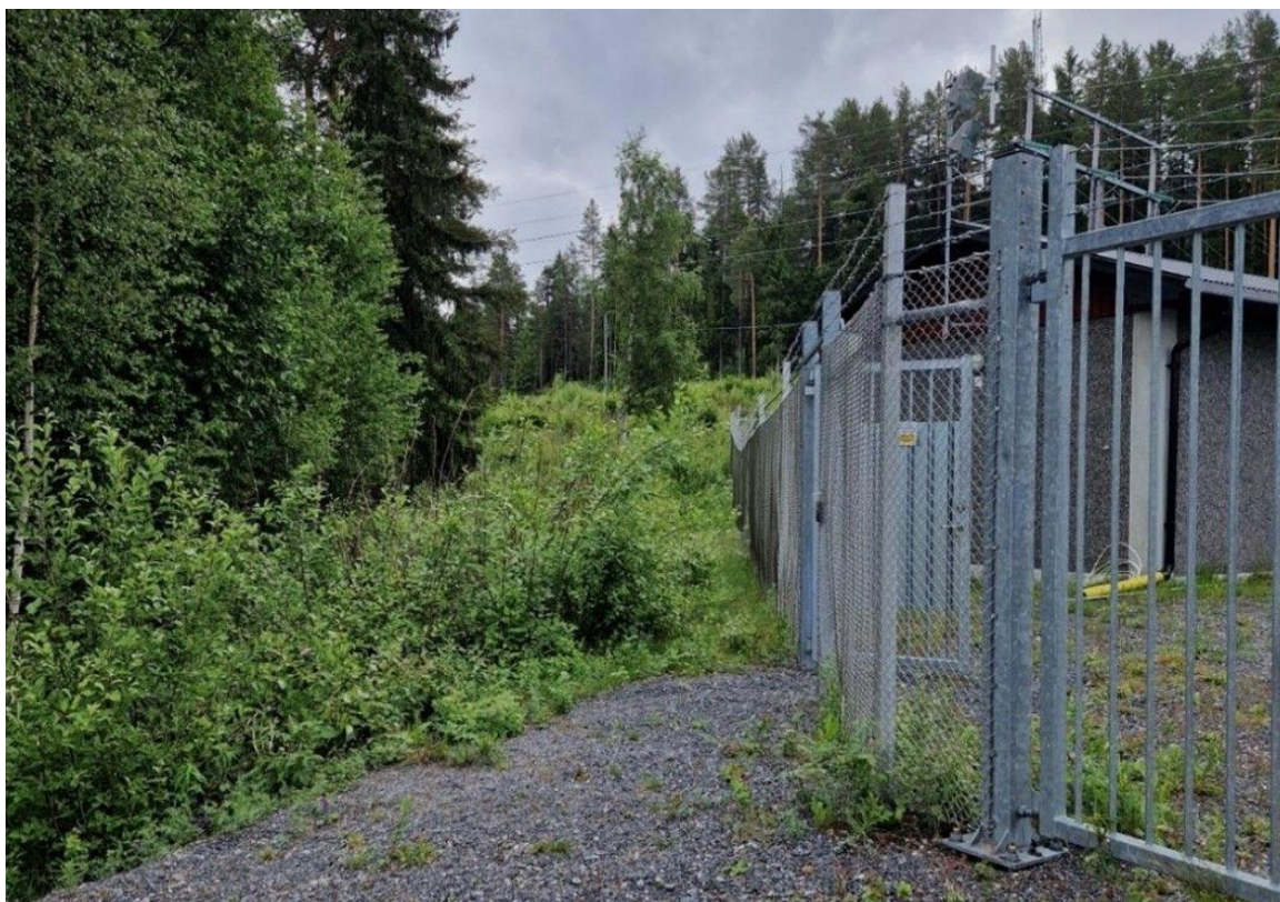
Figur 5: Del av aktuellt planområde med sly, träd och grusväg in till ställverket.
