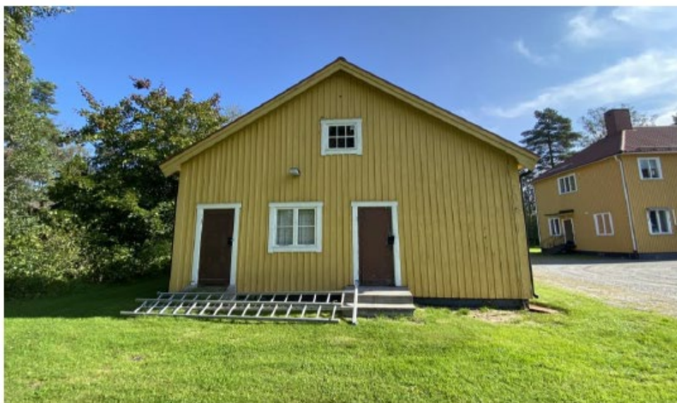
Figur 22. Garagebyggnaden på Hörneå 8:4.
