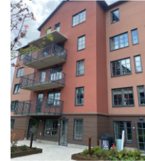
Utkragande balkonger som inte upptar för stor del av fasaden, Umeå kommun, Haga.
