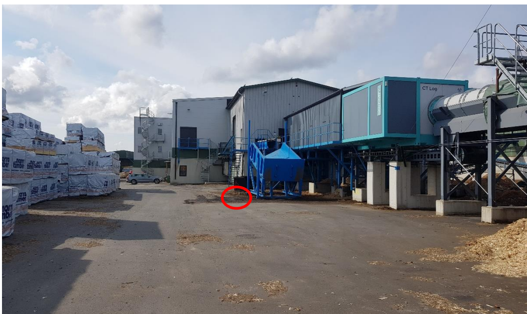
Figur 7. Centrala området, vy längs ledningsstråket mot syd, dagvattenbrunn finns vid den röda markeringen.
