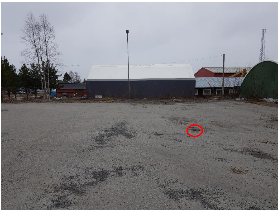
Figur 11. Parkeringsyta på Sävar 13:45, dagvattenbrunn finns vid den röda markeringen.
