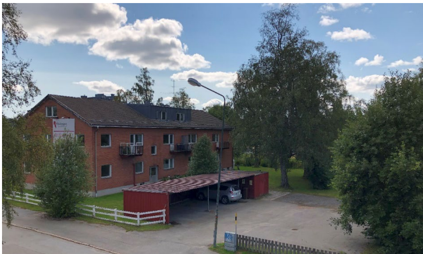
Befintlig byggnad inom planområdet. Vy från norr. Foto: Tyréns
