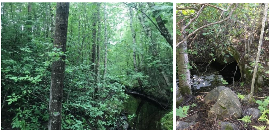
Figur 28. Till vänster är Öxbäcken söder om Kungsvägen och till höger visas befintlig trummyning Öxbäcken under Kungsvägen (Foto: WSP.)
