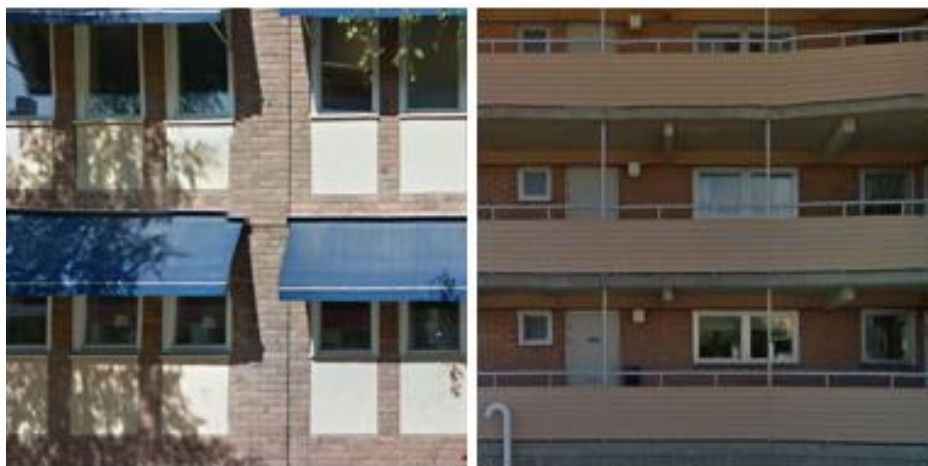
Figur 2. Repetition och tegel i planområdets närhet och inåtorienterade byggnader.
