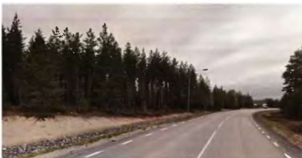
Foto: Nya Skravelsjövägen från väster
