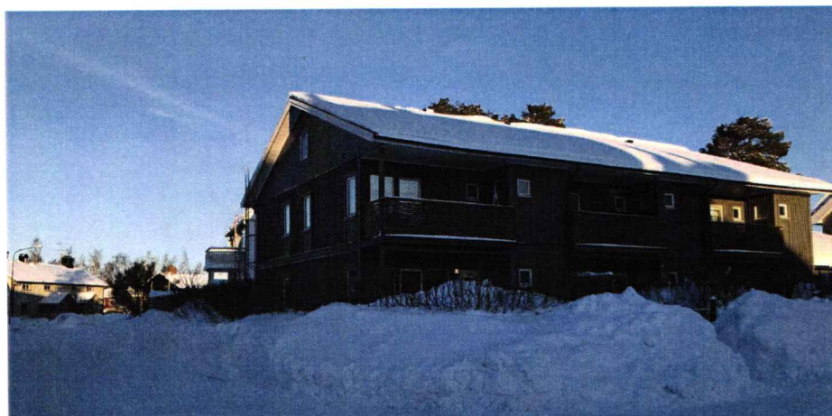
Byggnad längs Egnahemsvägen, direkt öster om planområdet (Foto: Tyréns AB 2021-01-29).
