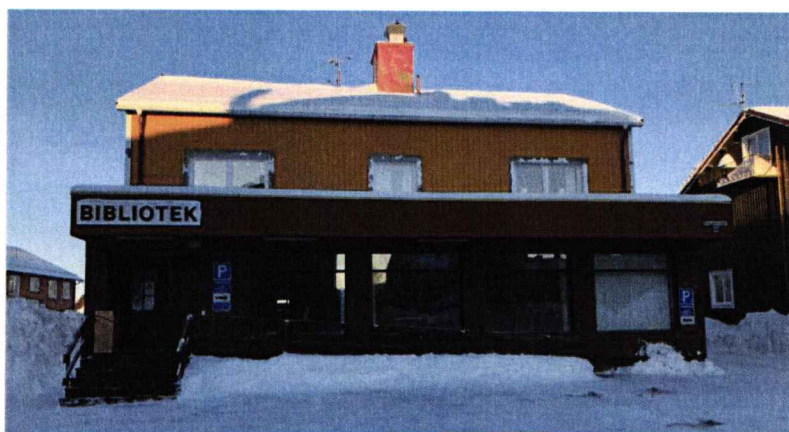
Foto 1: Huvudbyggnad inom fastigheten Lillskogen 5 (Foto: Tyréns AB 2021-01-29).
