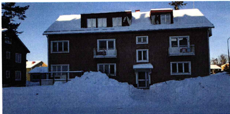
Foto 3: Huvudbyggnad inom fastigheten Lillskogen 3 (Foto: Tyréns AB 2021-01-29).
