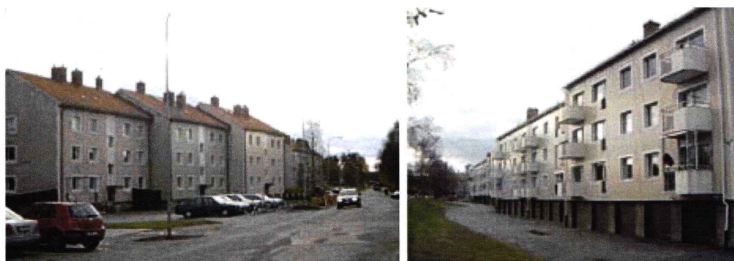
Bilder på bebyggelsen inom kv. Lodjuret (Källa: Byggnadsordning för TEG, 2006-11-20)
