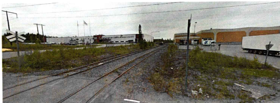
Figur 20. Vy över delar av det stickspår som löper öster om planområdet. Bildkälla: Google.
