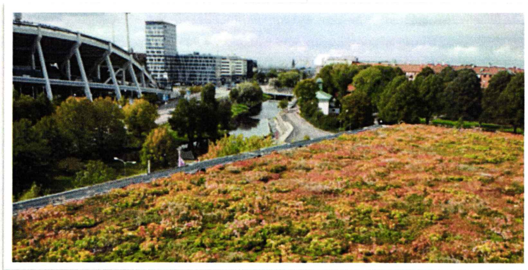
Figur 36. Exempelbild på gröna tak. Bilden är tagen från www.vegtech.se och visar ett sedumtak.
