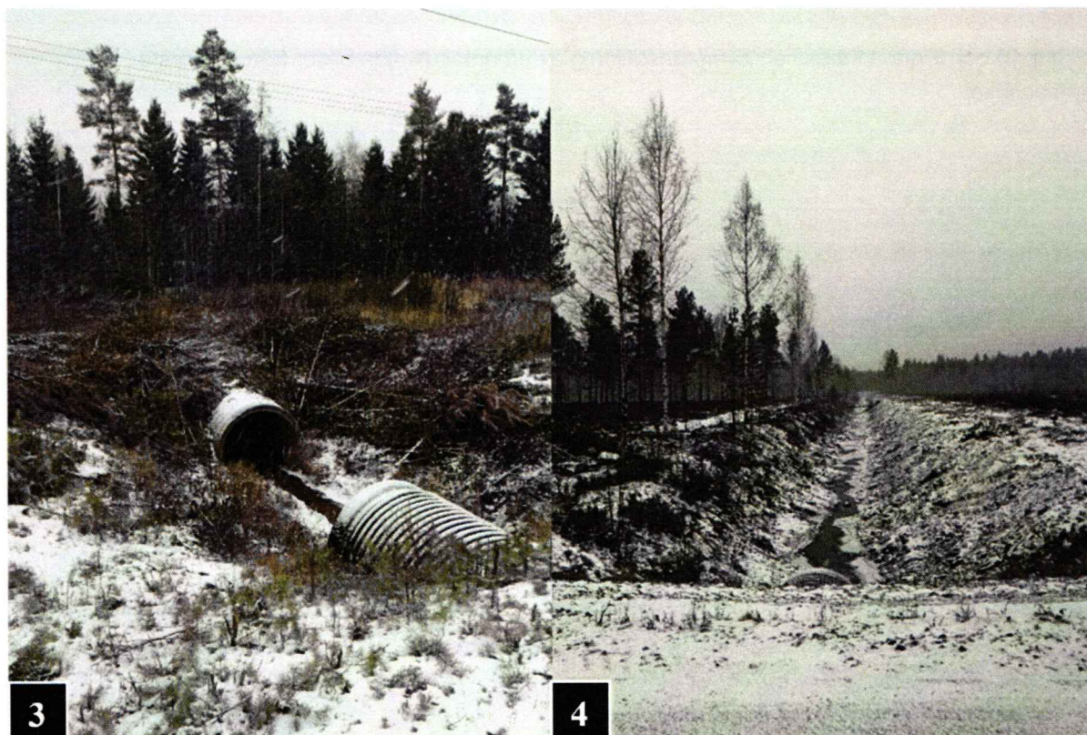
Figur 11. Bilder tagna på det planerade industriområdet. Bild 3 visar trumma under väg med vattenfyllt dike. Bild tagen från Lagervägen mot norr. Bild 4 visar dike som sträcker sig genom fastigheten. Bild tagen från Lagervägen mot söder.
