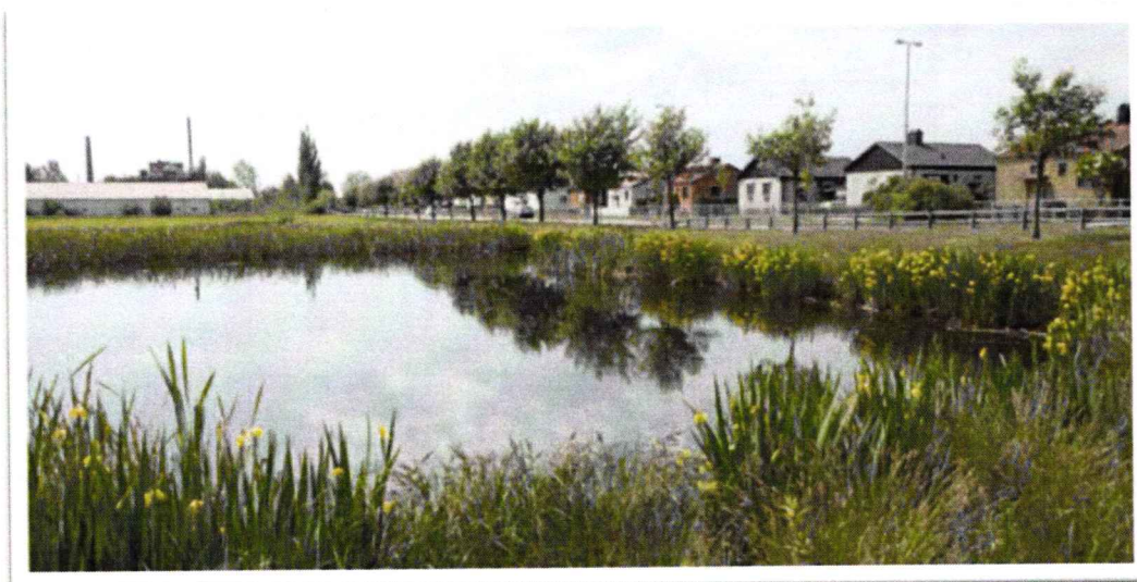
Figur 34. Ett exempel på en dagvattendamm i nordvästra Skåne. Bildkälla: NSVA:s hemsida.
