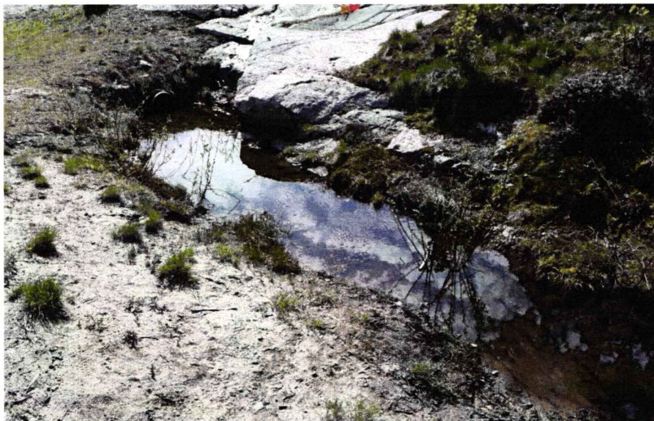
Figur 13. Dagvattenutlopp i befintlig gata.
