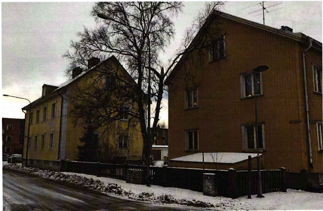
Bebyggelsen inom planområdet. Bild tagen från Järnvägsgatan.
