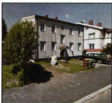
Bilden visar huvudbyggnaden inom Långmyran 6. Huvudbyggnaden är placerad med långsidan längs med Moritzvägen.
