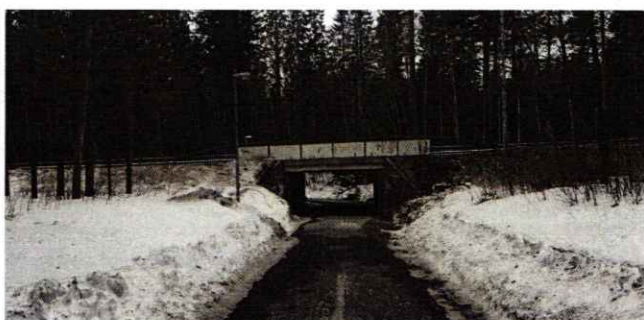
Passage under Ersmarksvägen
