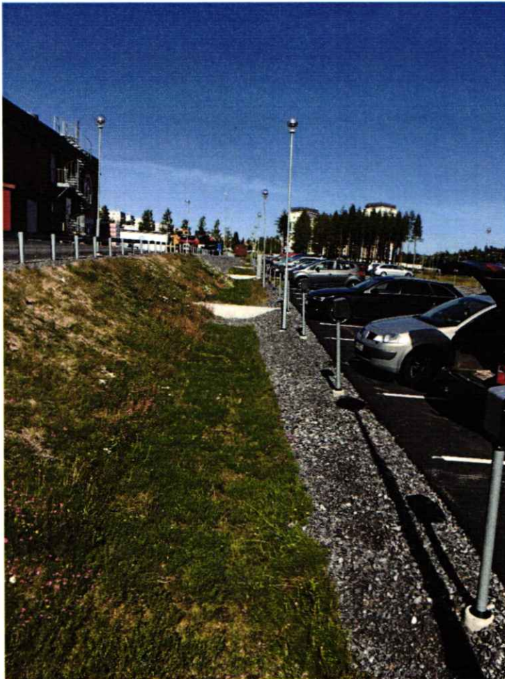
Figur 16. Exempel på ett svackdike som är sektionerat med hjälp av överfall. Bilden tagen av Sara Rebbling vid ICA Kvantum Mariehem, Umeå.
