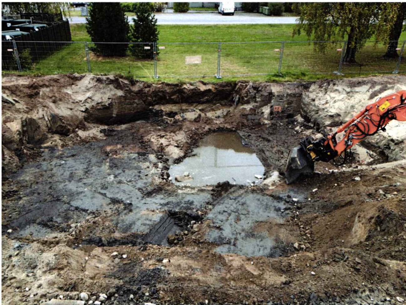
Bild 6. Översiktsbild över nästan färdigt schakt där BP-cisterner legat.
