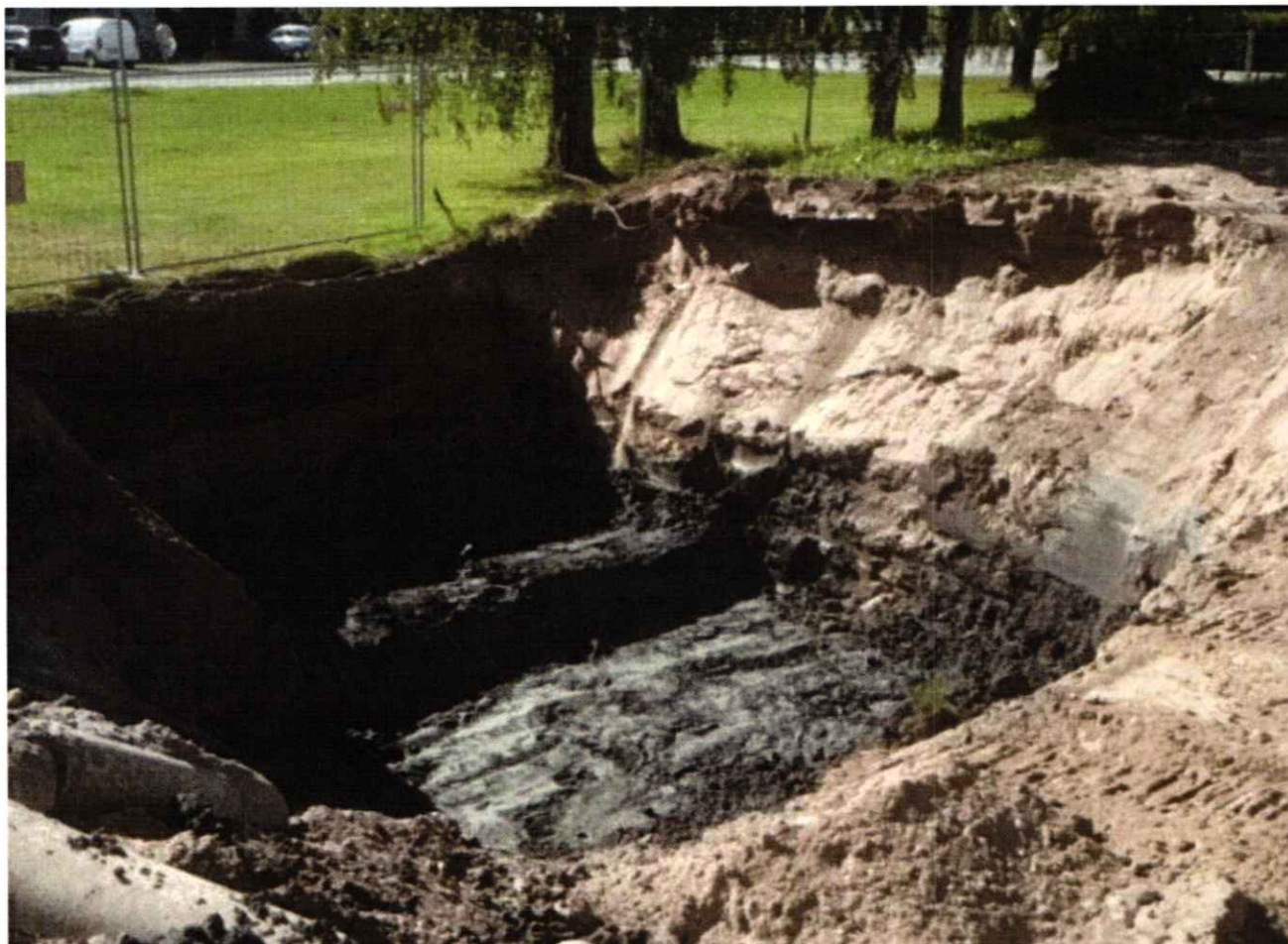
Bild 3. Schachtgröp där BP-cisterner återfanns, tidigt in i saneringen.
