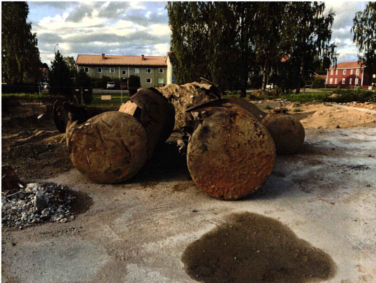
Bild 2. Påträffade cisterner tillhörande BP.
