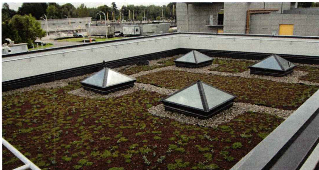
Figur 14: Nyanlagt grönt tak.
