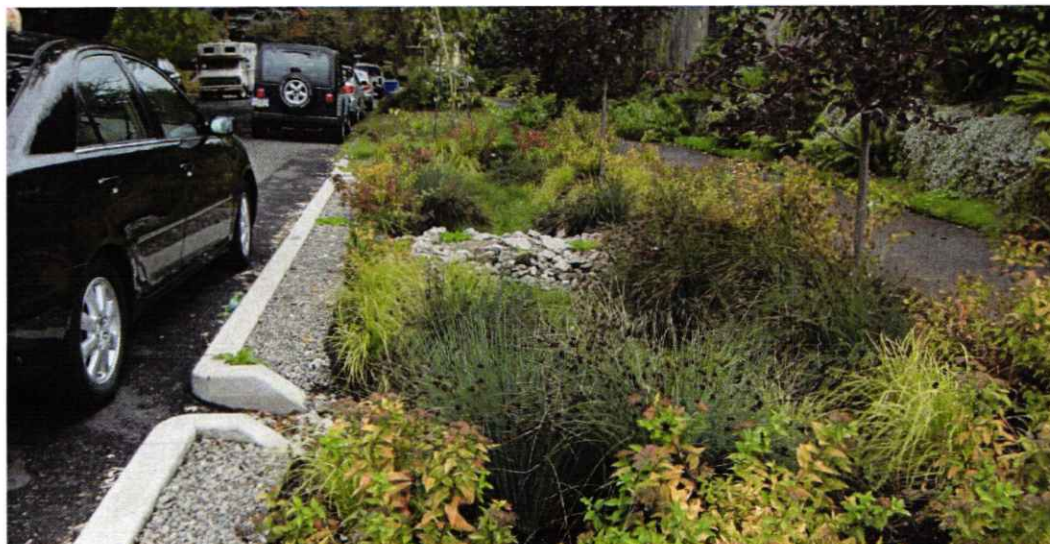
Figur 10: Exempel på dagvattenmagasin mellan gata och GC-väg.
