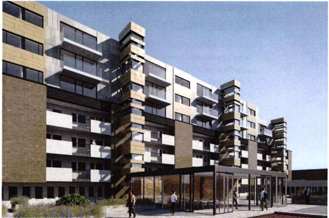
Gårdssidans på- och tillbyggnad
