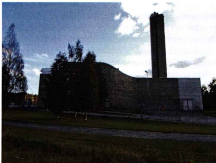
Värmeverket med dess skorsten sett från Ålidbacken i norr.
