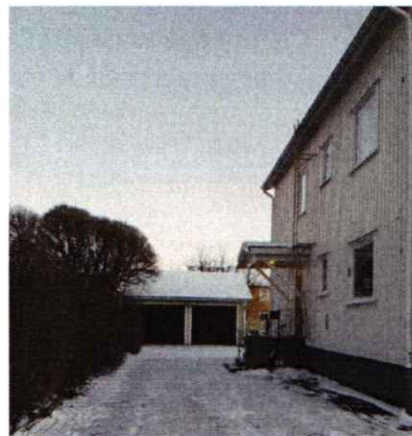
Entré och garagebyggnad
