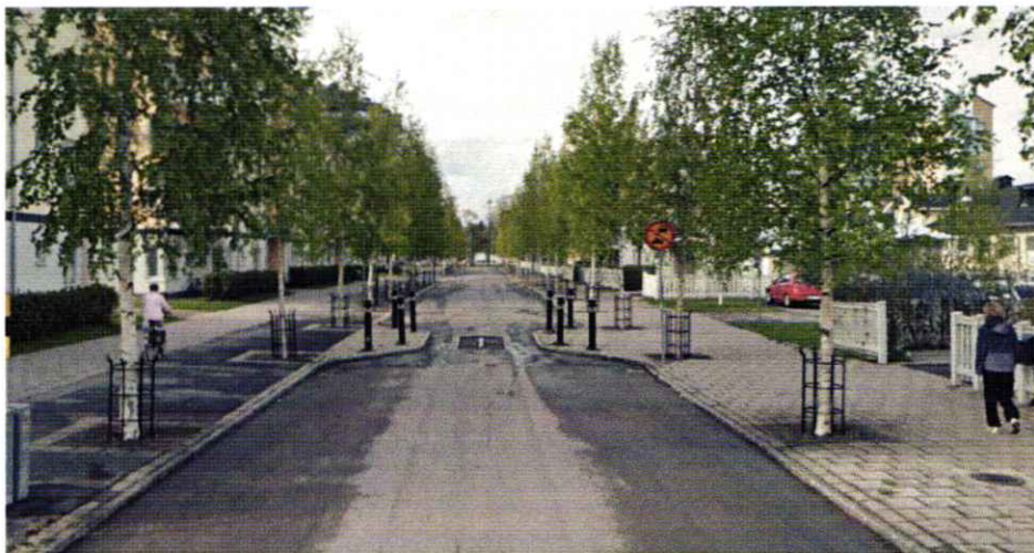
Figur 2.2 Brogatan mot norr med hindret för personbilar mitt i bilden. Foto från Google.
