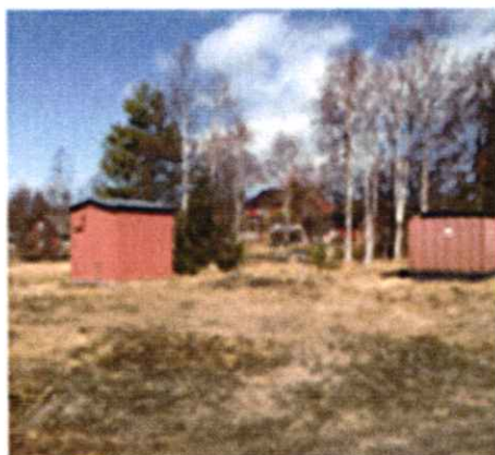
Telestation (Växtholm 3) uppförd 2009 samt transformatorstation.
