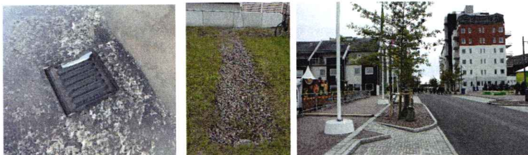
Översvämmad dagvattenbrunn inom Västerslätt. Exempel på utformning av svackdike och på växtbäddar i gatemark utformade för att ta hand om dagvatten (Vallastaden, Linköping).
