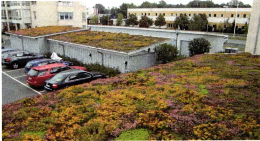
Figur 18. Exempelbild på gröna tak. Bilden är tagen från en dagvattenbroschyr "Ta hand om dagvatten- Råd vid planering och byggande av flerbostadshus" gjord av Miljö- och samhällsbyggnadsförvaltningen i Huddinge kommun (2014).
