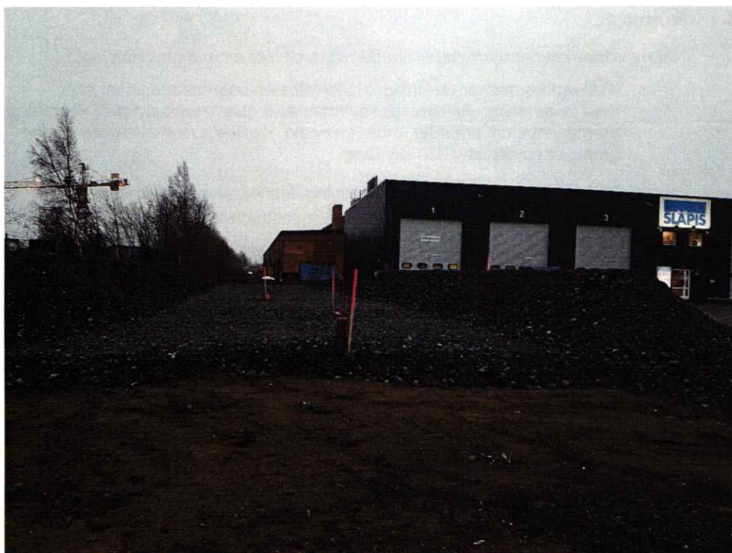
Figur 4. Grundläggningsarbete har påbörjats vid provtagningspunkt 20 vid Släpis AB. Se Bilaga 3 Fältprotokoll för samtliga avvikelser och kommentarer.
