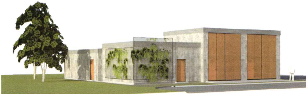
Fasad vy från sydväst
