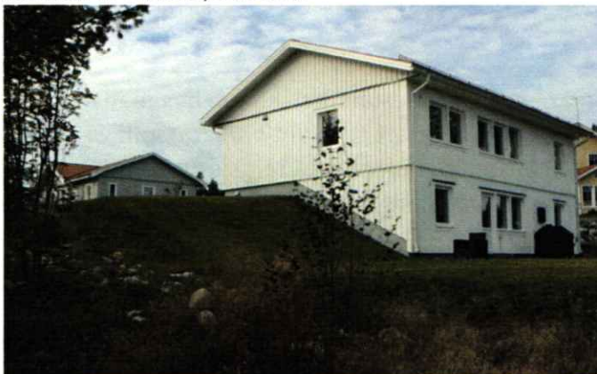
Suterränghus på fastigheten Sävar 66:234.
