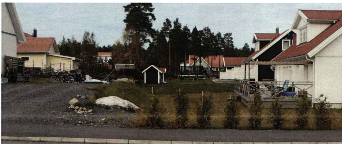
Exempel på slänter mellan fastigheter längs Hällebergsvägen.
