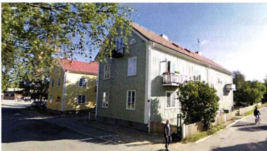
Korsningen Dragongatan/Smedsgatan med fastigheten Spiltan 4 (t.v.) och Umeå 5:2 (t.h.). Bostadshuset på fastigheten Umeå 5:2 totalförstördes i en brand i september 2014.
