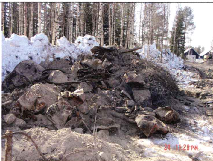
Utrensat metallskrot som påträffades i samband med schakt för avloppsledning.
