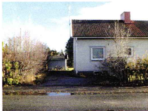
Infart/parkeringsplats till det västra bostadshuset.
