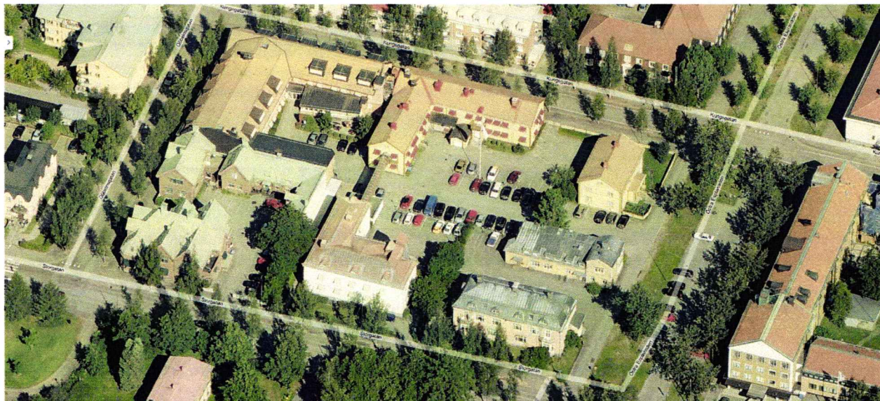
Kv Tyr innan rivningen av "Rosa huset" (Tyr 3) påbörjats.
