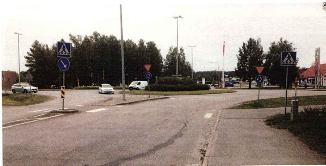
Fotografi 5-4: Gång- och cykelvägens passage av Gräddvägen (3) bör få en tydligare utformning mellan gående/cyklister och bilister.
