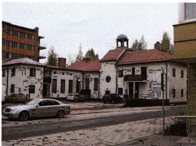
Befintlig byggnad mot gården...
