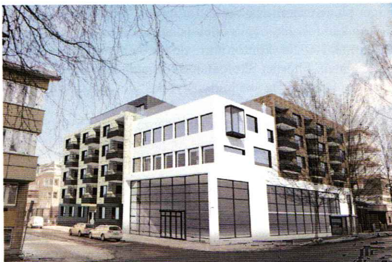
... och efter nybyggnad.
