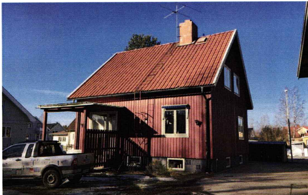
Figur 5 Bostadshus inom fastigheten
