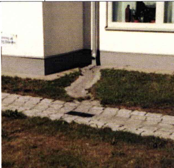
Figur 6. Utkastare med förstärkt infiltration.
