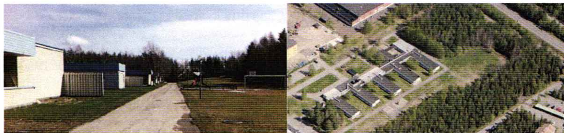
Befintlig bebyggelse på fastigheten Stadsliden 6:3.
