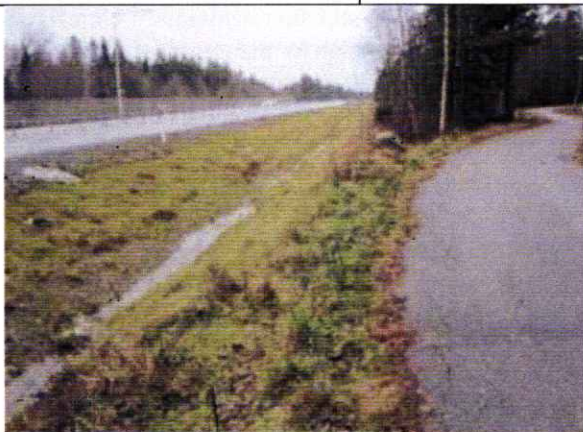
Figur 3. Dike vid väg E4.
