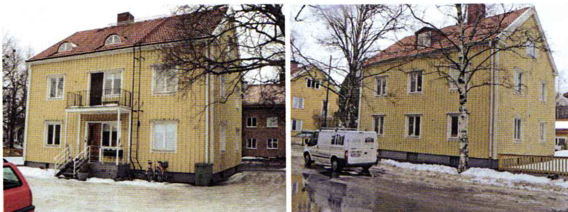
T.v. Huvudbyggnad sett från gårdsplan. T.h. Huvudbyggnad sett från Östra Norrlandsgatan.
