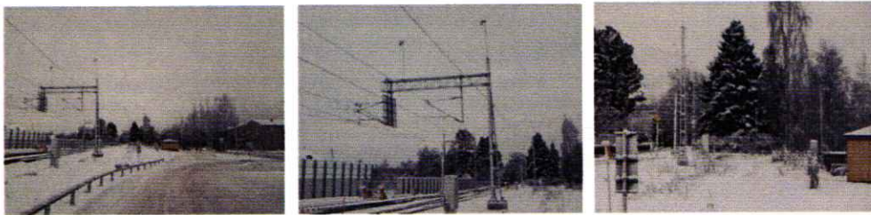
Bild 1, 2 och 3: Område för planerat parkeringshus vid Umeå C
