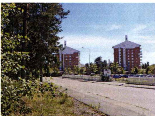
Kuratorvägen vid parkering mot Ålidhöjd
