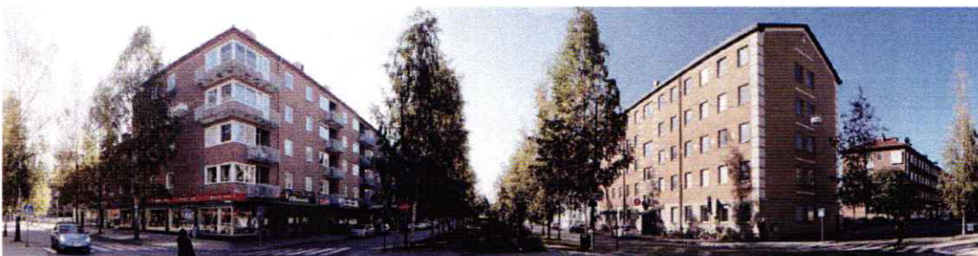
Vy åt söder längs Rådhusplanaden. Rind 11 till vänster och Fabriken 8 till höger.
