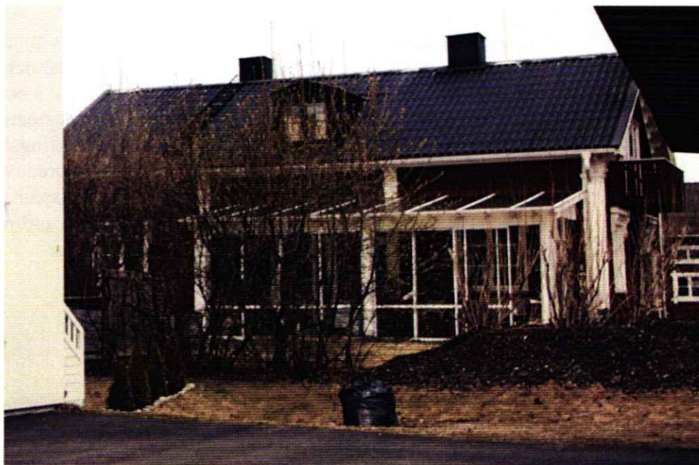
Södra fasaden med tillbyggt inglasat uterum och takkupa.
