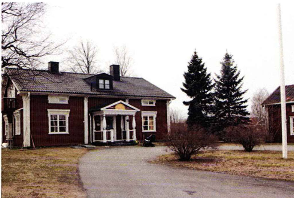
Mangårdsbyggnaden inom Rosen 3 sett från norr.
