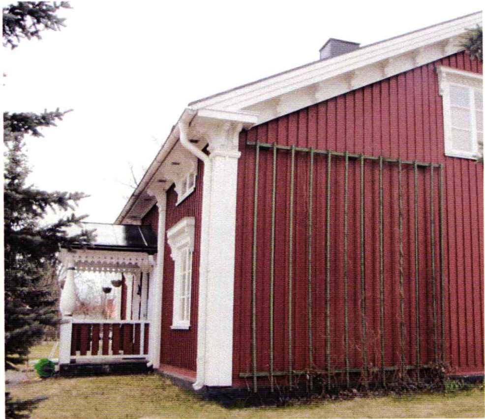
Dekorativt utformade knutpilastrar, takfot och taktassar. Fotografi; Västerbottens museum.
