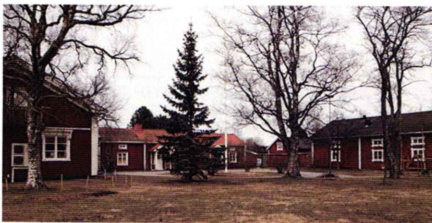
Gårdsgrupp inom Rosen 3 med huvudbyggnad, bagarstugulänga och ekonomibyggnad sett från öster.
