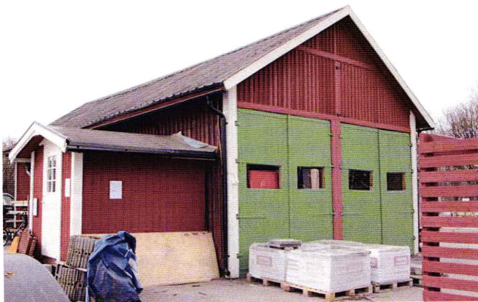
Uthusbyggnad inom Rosen 3 sett från norr.
