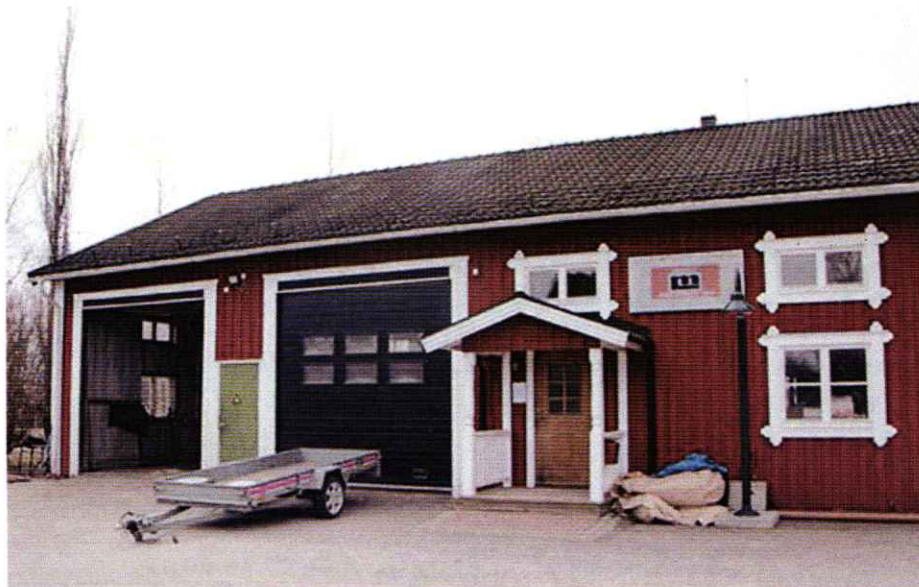
Ekonomibyggnad inom Rosen 3 sett från norr.
