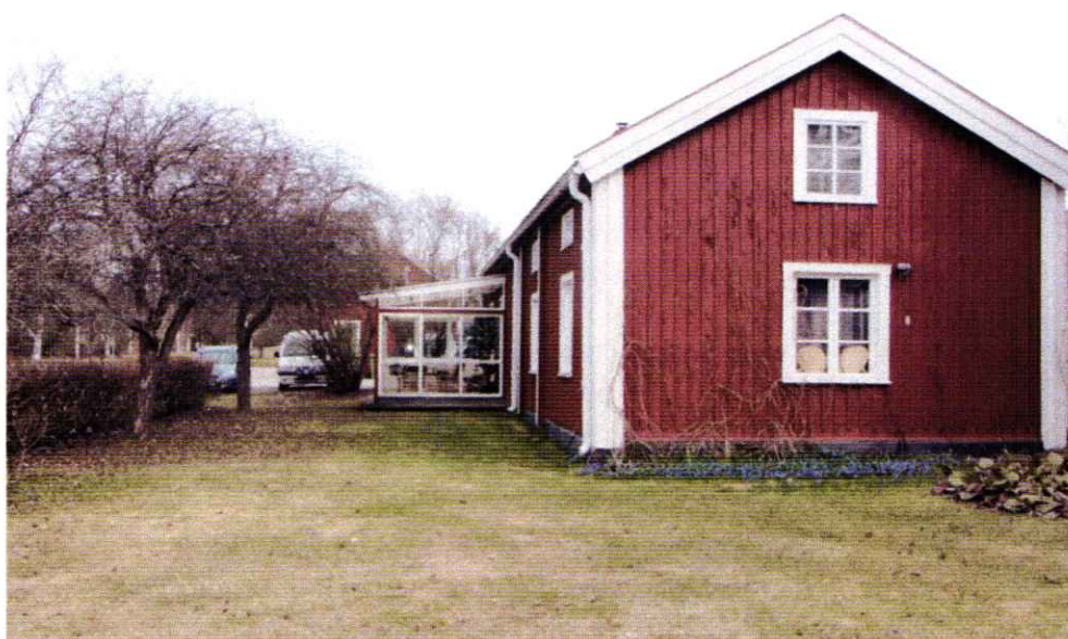
Tillbyggt uterum. Sett från söder.
