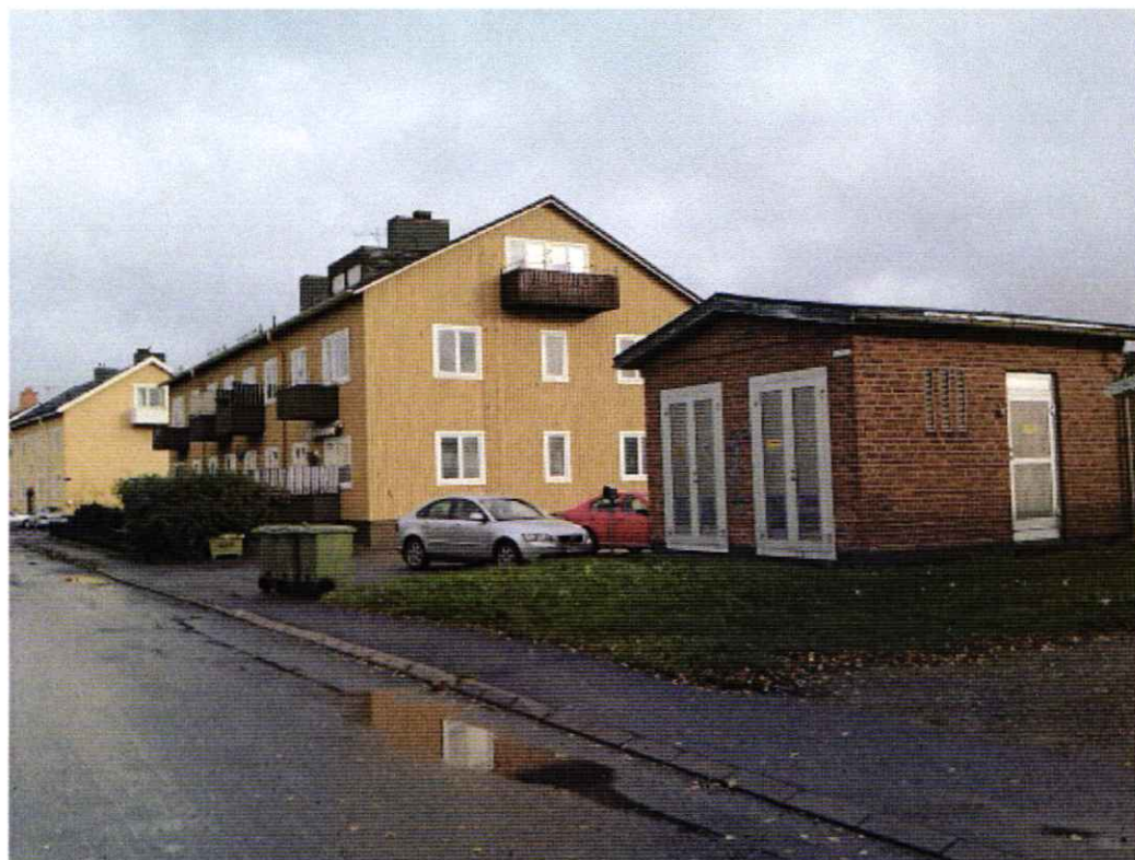
Befintlig byggnad på Nötskrikan 1 med intilliggande transformatorstation.
