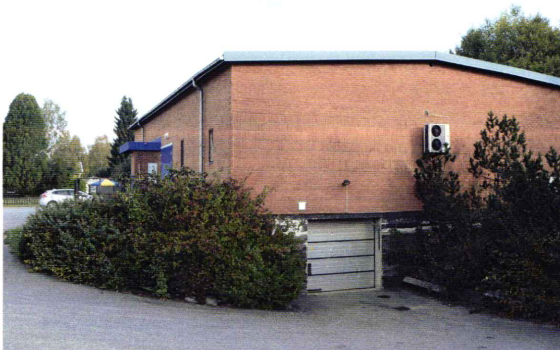
Byggnadens södra gavel som visar ramp till källarplan.
