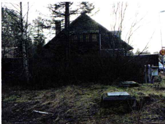
Betongkonstruktioner och luftningsrör
