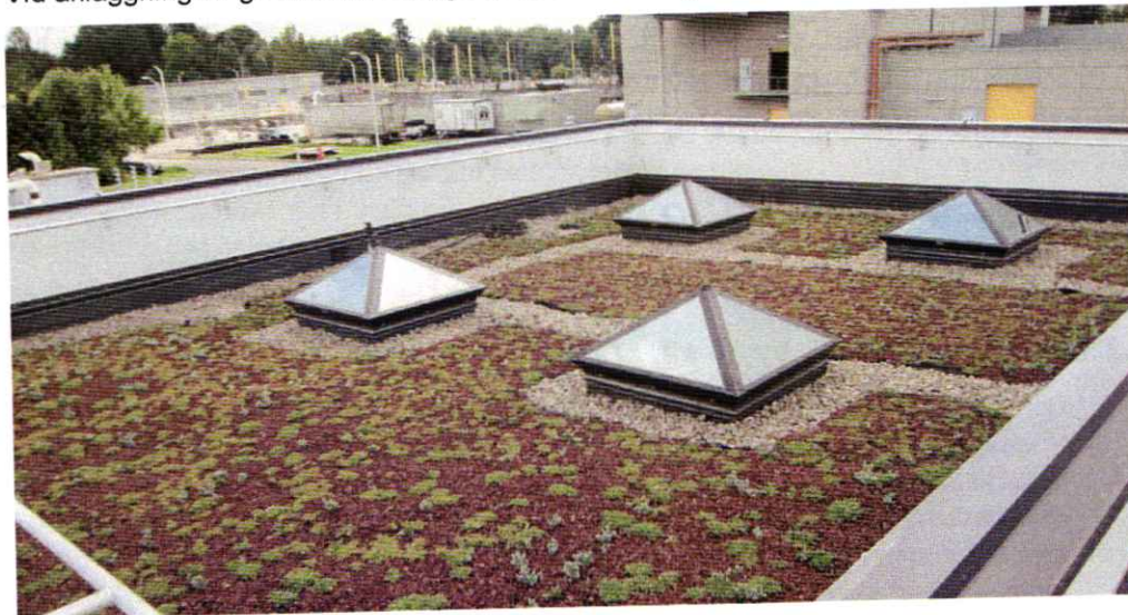
Figur 14: Nyanlagt grönt tak.
