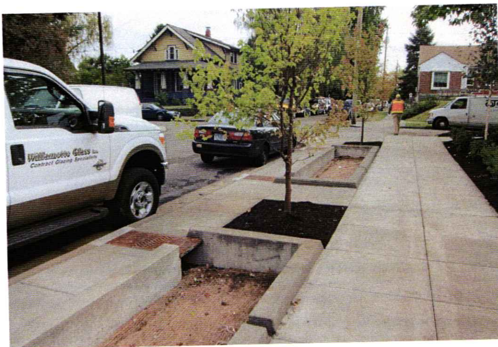
Figur 11: Exempel på dagvattenmagasin under uppförande mellan gata och trottoar.
