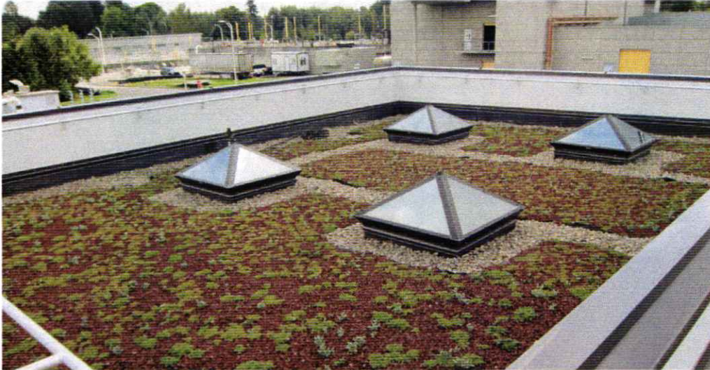
Figur 9: Nyanlagt grönt tak.
