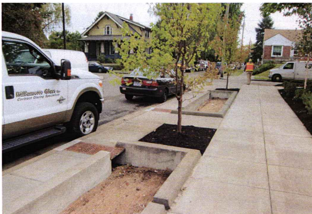
Figur 6: Exempel på dagvattenmagasin mellan gata och trottoar.
