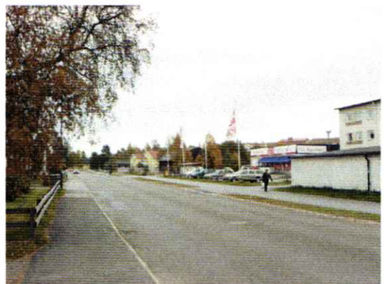
Ängsvägen mot norr.
