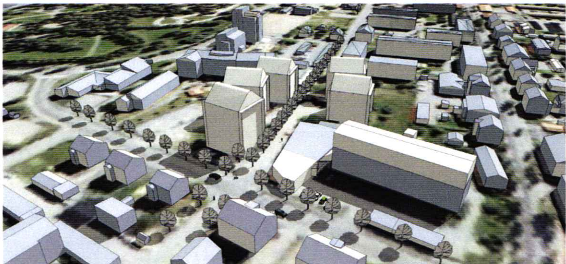
Sett snett uppifrån mot nordöst.
