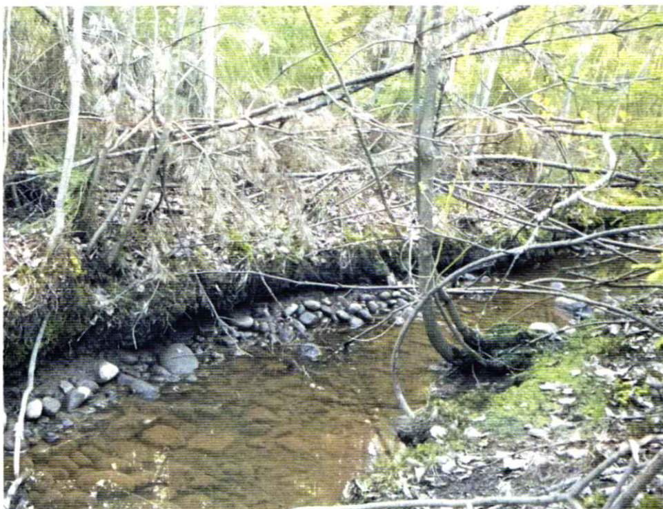
Figur 8 Dagvattnets väg från utsläppspunkt till Noret (ca 150m öppet dike). Foto: Marie Boström
