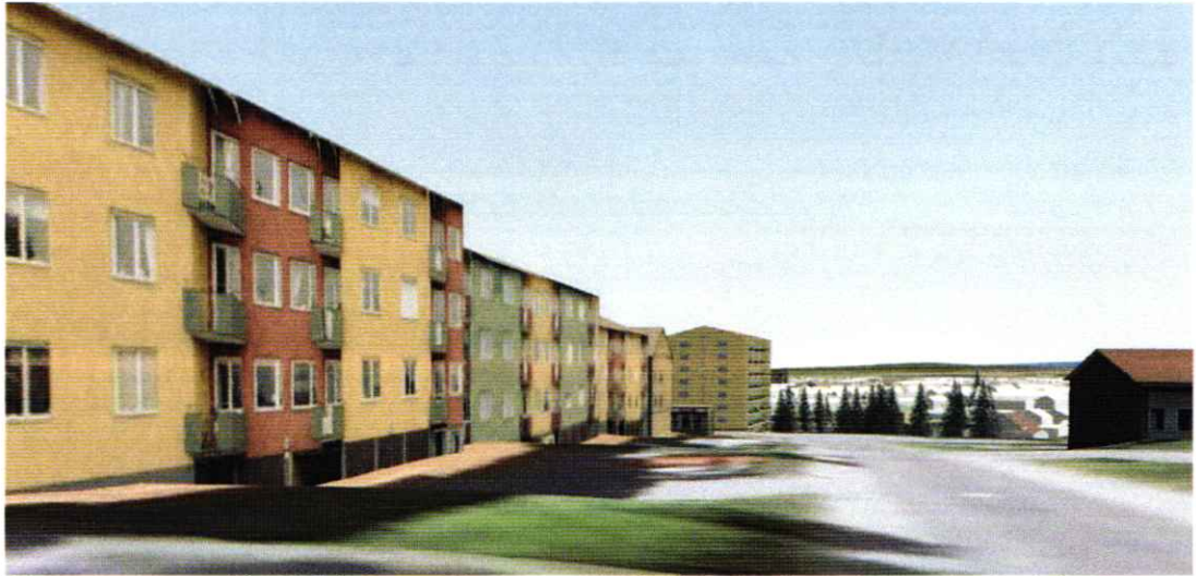
Illustration, vy sett från Nydalavägen. Eftersom marknivån ligger ca 3 meter lägre där sjuvåningsbyggnaden står än den ovanstående bebyggelsen kommer sju-våningsbyggnaden inte att upplevas som lika hög uppifrån Berghem. Bild ur Umeå kommuns 3-d modell
